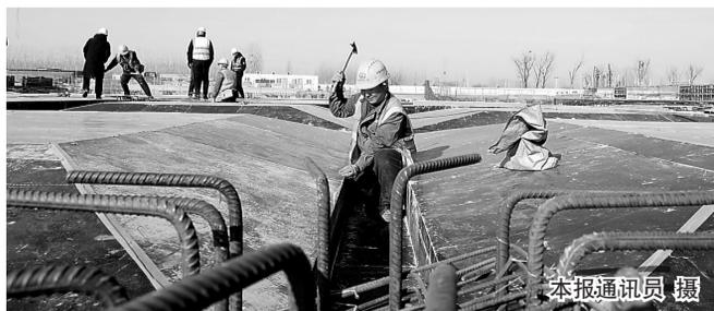
本报讯(通讯员 刘巨雷 记者 李圣哲)连日来,京雄商高铁肃宁东站配套设施(地下车库)建设项目紧张施工,工作人员加紧进行车库顶端防水、混凝土剔凿和地表线路铺设等工作(上图)。这标志着该项目取得了阶段性进展,为后续
