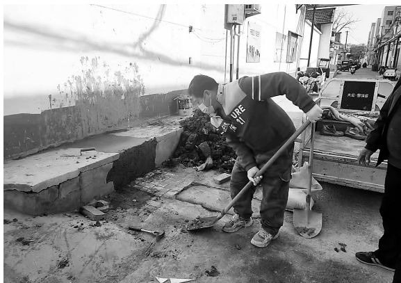
为方便居民出行，营造良好的辖区环境，近日，新华区祁孟庄社区党群服务中心修缮了祁孟庄东街的下水道，以防污水外溢。 路冬晔 摄
