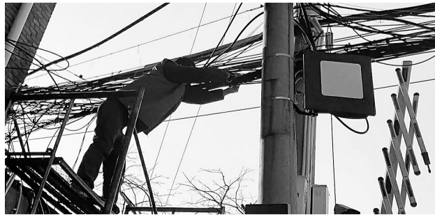
近日,运河区团结小区社区请来专业维修人员,对团结小区居民楼前杂乱的线缆进行梳理。 崔春梅 邹泽宁 摄
