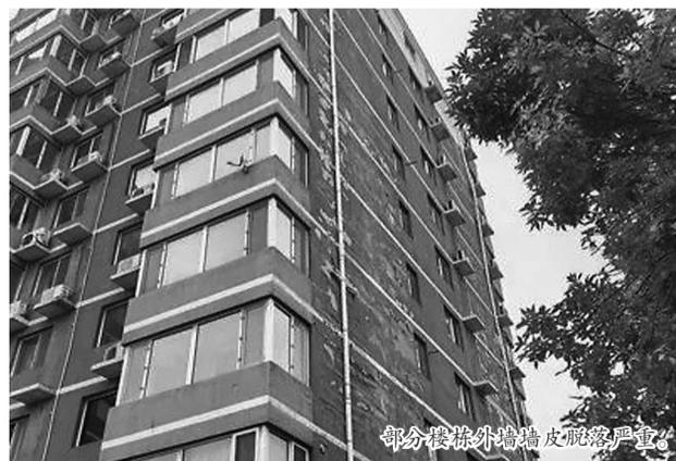
部分楼栋外墙墙皮脱落严重。
