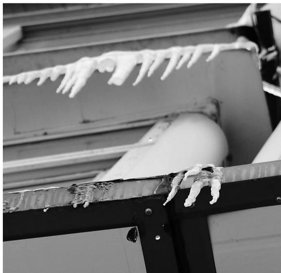
正好下雪,部分融化的雪水流到挡板的边缘处结了冰,形成冰锥悬挂在挡板边缘下方(左图)。随着融化的雪水越来越多,冰锥像钟乳石那样越来越长。
