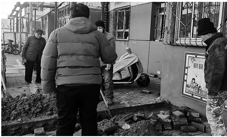
办法便是更换新管道。胡春江多次入户协调,最终帮助大家确定了更换管道这一方案。
