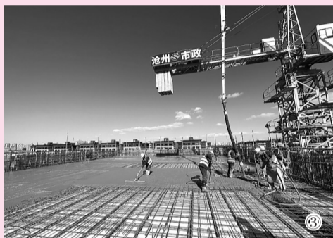
图①:市政公司董事长吴英彪(右二)在南方电网广州供电局220千伏联通输电变电工程现场 图②:市政公司董事长吴英彪(左二)在广东省清远市辖区工程现场 图③:沧州市运河区文化活动中心建设项目主体工程顺利封顶
