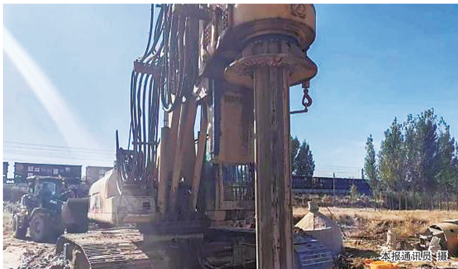
土顶进行程44.93米,空顶行程6.48米)。 据悉,曲港高速公路连
