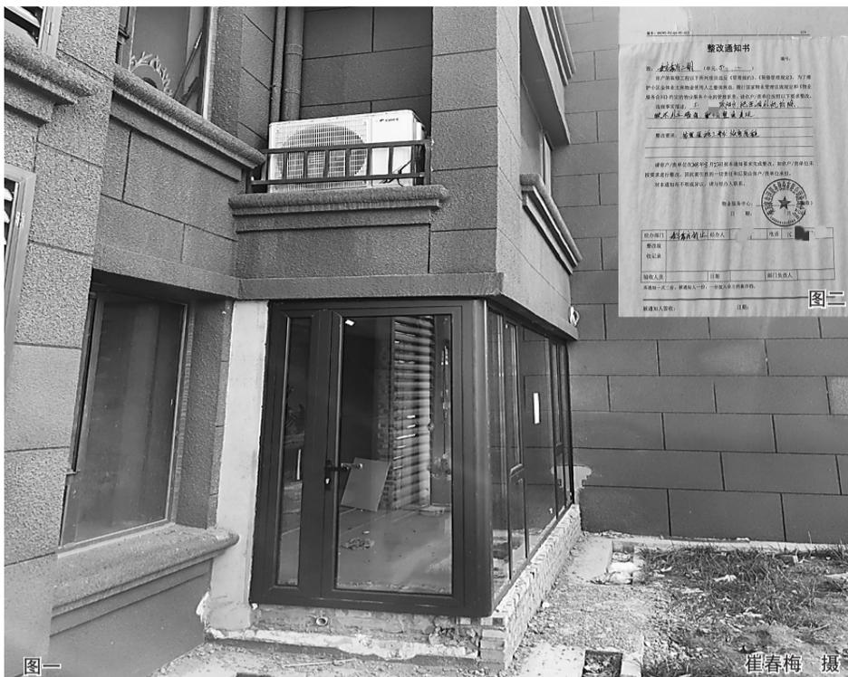
2021年交房的,已经入住了1年多,楼上不少居民已经装修入住。前些天,有人在邻里微信群里说,本楼一楼的一户居民装修时,砸掉了南侧阳台的外墙。大家担心一楼居民砸掉的是承重墙,换成几面带框的玻璃“支撑”有安全隐患。由于当时现场只有装修人员,他们并没有见到房主。大家将此事反映给小区物业公司,但一连多日过去,一楼阳台的两面墙依然保持带框的“玻璃墙体”模样。
