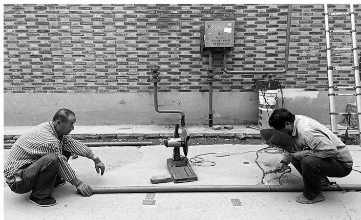
日前,新华区祁孟庄社区党员干部请来华润燃气施工人员,为光华新村村民改造调压箱,消除安全隐患。 杜新蕊 摄
