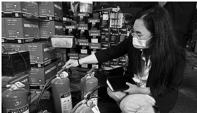
日前,新华区祁孟庄社区组织党员干部对辖区重点点位进行安全检查,确保安全无事故。 杜新蕊 摄
