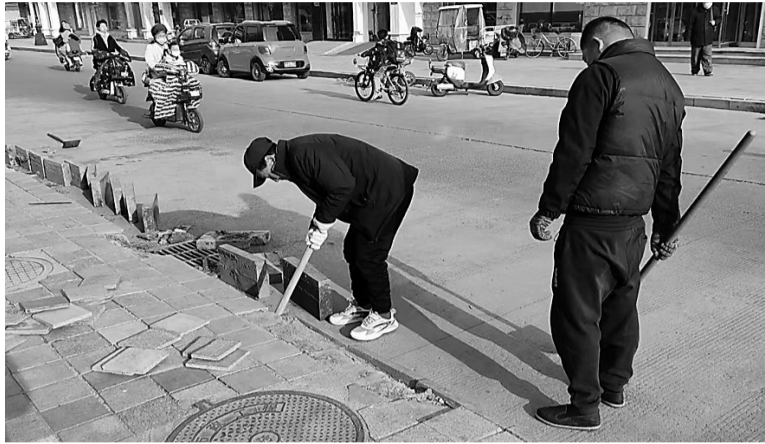
砖被更换完毕。
