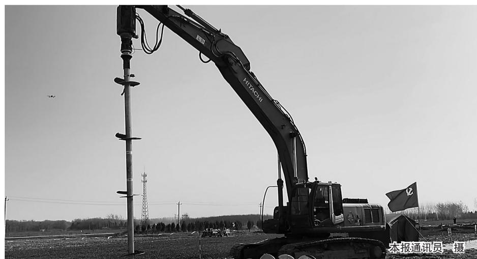
设部副主任刘鑫介绍,这颗巨型“螺丝钉”形成的抗压承载力达240千牛、抗拔承载力达234千牛,相当于可
