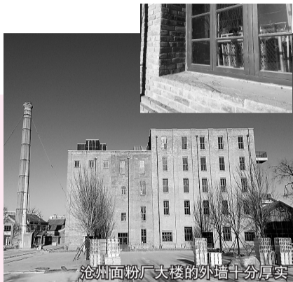
沧州面粉厂大楼的外墙十分厚实
