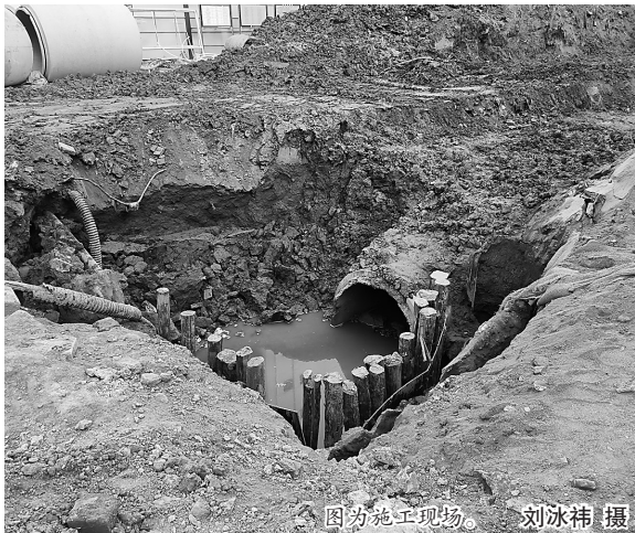
图为施工现场。 刘冰祎 摄
