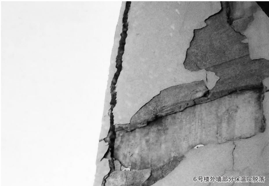
6号楼外墙部分保温层脱落
