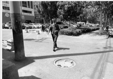
地址: 九河西路滨龙韵西区东侧便道上有一井盖塌陷损坏, 井盖低于路面10厘米, 低洼处还有石块等。希望有关部门尽快修复, 让井盖与路面齐平。
