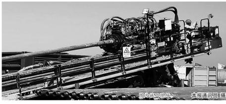
穿越工程,是目前国内企业实 施的管径最大、距离最长、难 度最高的对海定向钻工程。这 项工程对钻杆的性能和质量 要求极高,钻杆需要承载千吨 以上的回拖拉力,施工中不能
