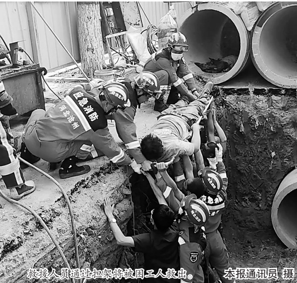
救援人员通过担架将被困工人救出。 本报通讯员 摄
