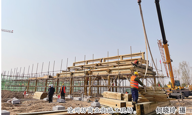
沧州坊商业街施工现场。何晓玲 摄
