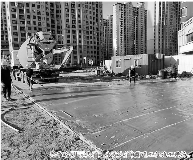
熙平路(开元大道—永安大道)贯通工程施工现场。
