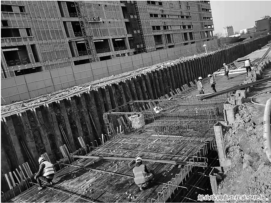
解放路调直工程施工现场。
