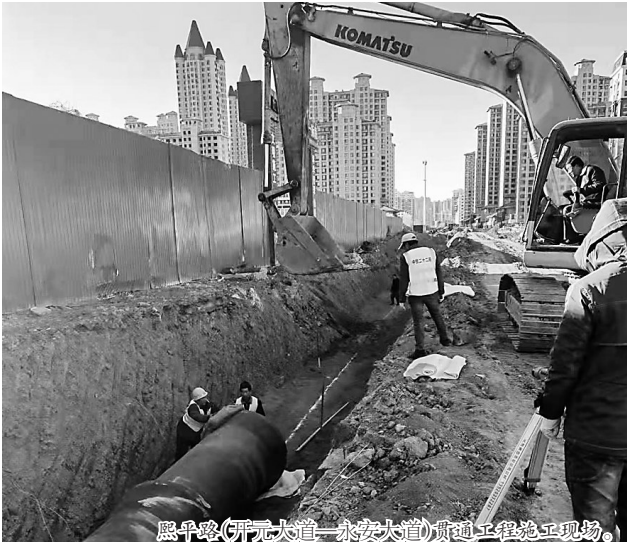
熙平路(开元大道—永安大道)贯通工程施工现场。
