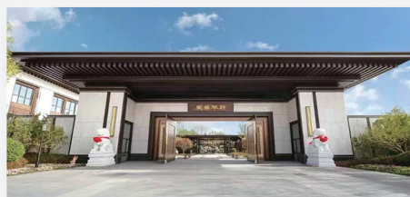
沧州·荣盛华府项目大门实景图
