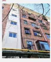
运河区南新村小区11号楼2单元 从6楼楼顶往楼下住户垂接着黑色软 管。里面的白色PVC管部分裸露,软管 随风晃来晃去,存在安全隐患
