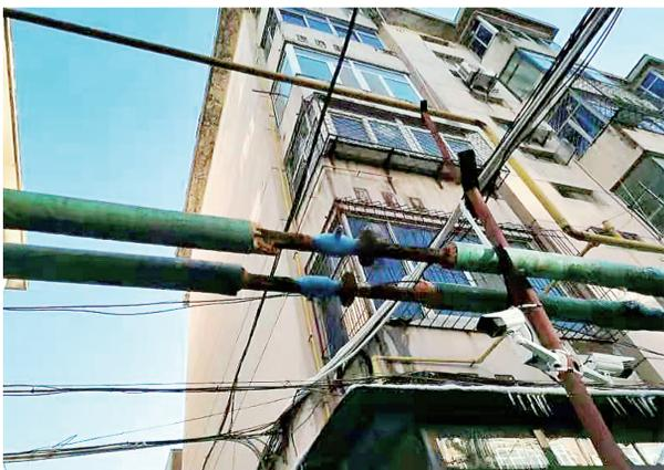
**【市民反映】** 近日, 市民王先生向记者反映: 运河区房产统建楼小区的暖气管道保温层缺失了不少。天气越来越冷, 居民希望相关部门尽快为管道裹上保温层。
