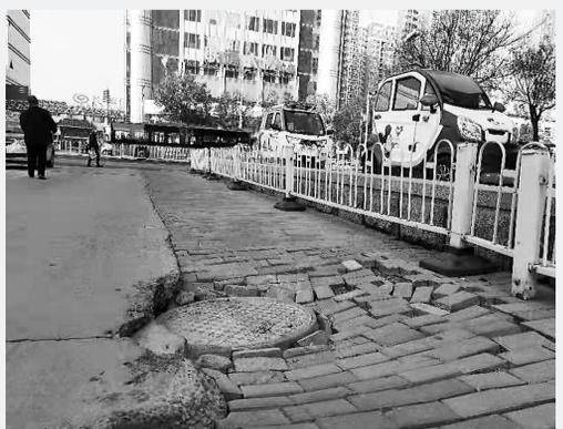
市区沧州饭店东侧的小马路上,一个井盖周围地砖破损,造成井盖塌陷,存在安全隐患。希望有关部门尽快处理。
