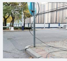
市区浮阳北大道与化机路交叉口西北角,一 根线缆垂落到地上。线缆一头的绝缘皮破损,露 出了里面的细线。希望相关部门尽快对垂地线缆 进行处理,消除安全隐患。
