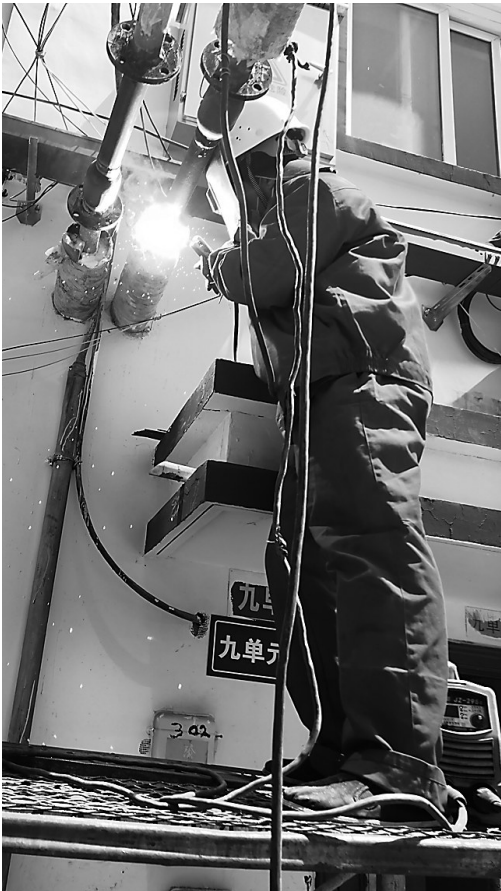
图片均为“昊天热力”工人维修供暖设备。
