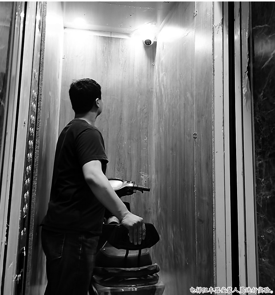
电梯阻车器安装人员进行实验。
