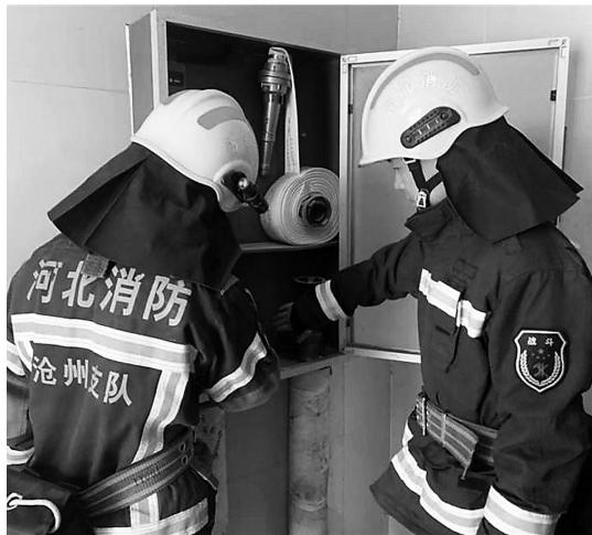
近日,河间市消防救援大队城垣东路消防救援站对辖区高层住宅小区进行消防隐患排查。卢扬 摄
