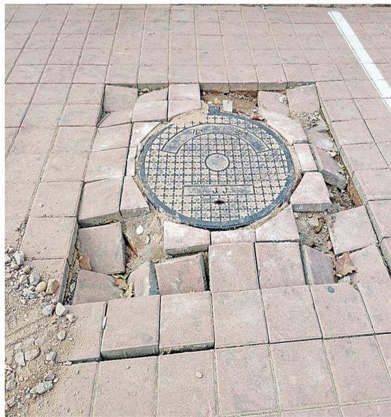
【读者反映】 近日,市民张女士向记者反映:在市区解放西路和永安南大道交叉口西南角的便道上,有个井盖周围的方砖塌陷了。行人稍不注意就有可能被绊倒,希望相关部门能尽快将塌陷的方砖复位。
