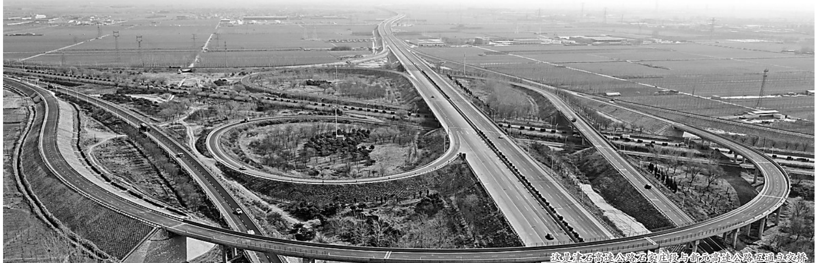
这是津石高速公路石家庄段与新元高速公路互通立交桥
