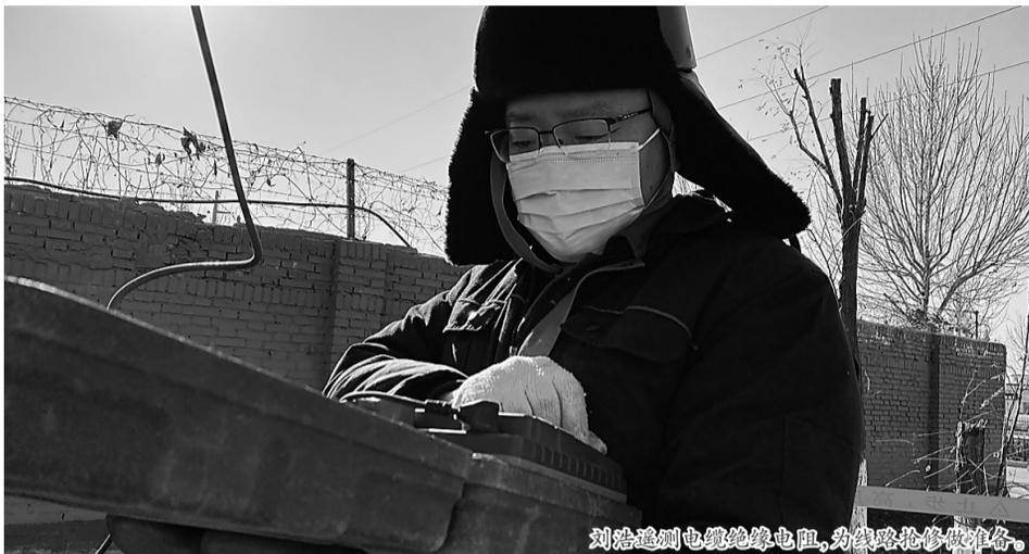
刘浩检测电缆绝缘电阻,为线路抢修做准备。
