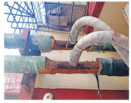
【市民反映】近日,家 住运河区梨园小区1号楼1 单元的闫女士很是心烦:她 家单元楼门口有两截供暖管 道的保温层缺失。天气越来 越冷,供暖管道没了保温层 的包裹,管道热量白白流失, 她担心会影响到室内温度。
